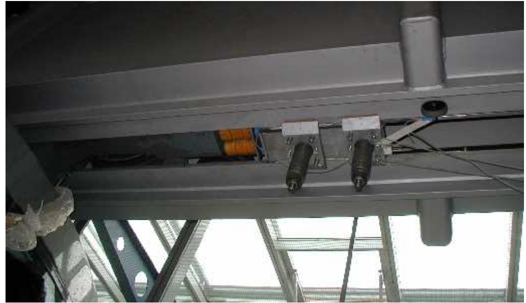
Bremspuffer mit Sensoren
